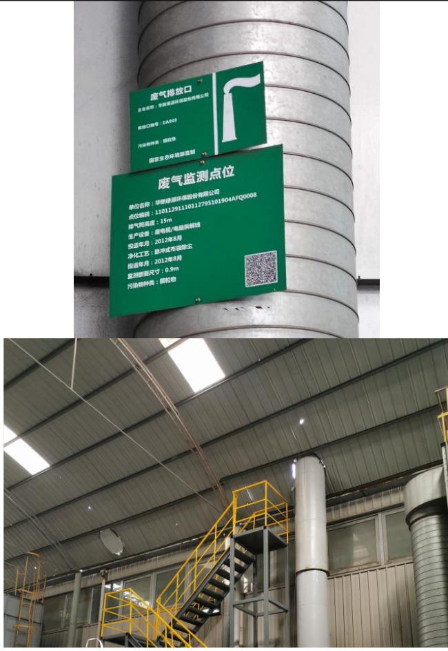
电视/电脑线污染防治设施 DA008
